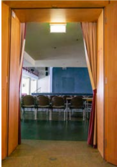
ZUGANG GROSSER SAAL BREITE: 1,46m
