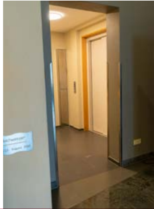
DURCHGANG FAHRSTUHL ZUM GROSSEN SAAL BREITE: 0,99m
